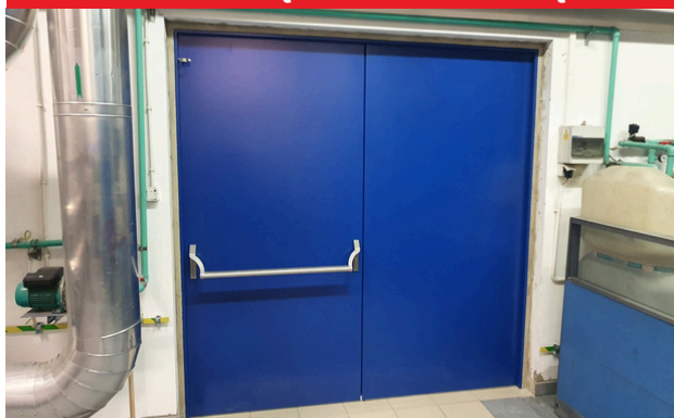
DRZWI PRZECIWPOŻAROWE Z DŹWIGNIĄ ANTYPANICZNĄ
