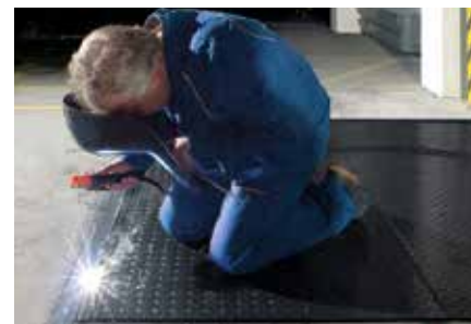
Spawanie do kątowników krawędziowych – gotowe!
