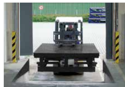
Osadzanie nowej ramy przeładunkowej
